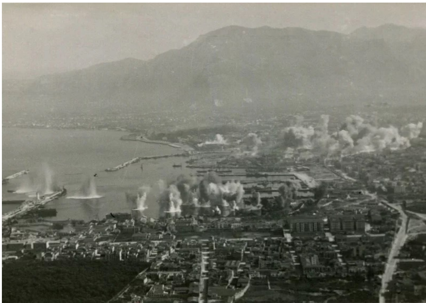
Palermo, marzo 1943, La zona del porto, la Cala ed il centro storico, sotto le bombe.
